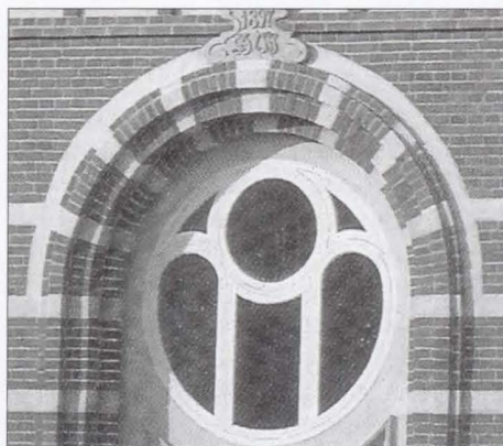
Efter renoveringen i 1994. Foto: Privateje.
