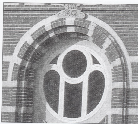
Efter renoveringen i 1994. Foto: Privateje.
